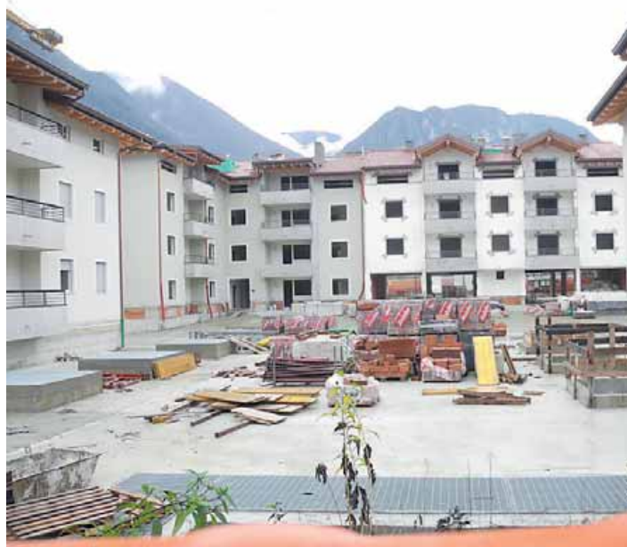
• Case Itea in costruzione
